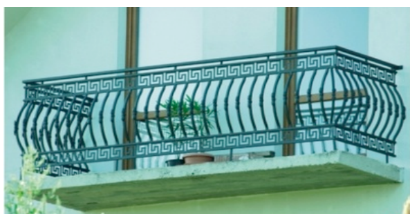
Zewnętrzna balustrada w greckim stylu BKZ 011
